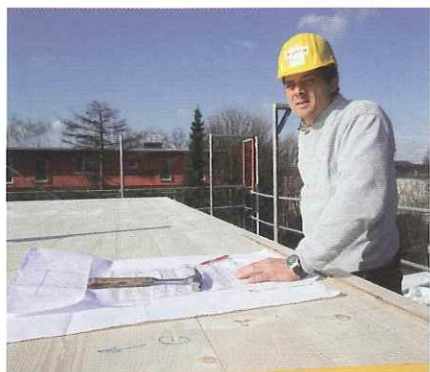
Vor Ort ist Arno Brendel verantwortlich für die Ausführung der Holzbau-Arbeiten.
