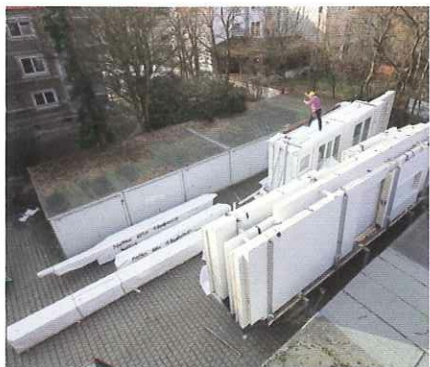
Fertige Wandelemente warten auf ihre Montage.
