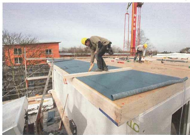
Drei Tage benötigen die Holzbauer im Schnitt, um eine Einheit zu erstellen, am dritten Tag folgte auf die Wände die Decke aus Brettsperholz.
