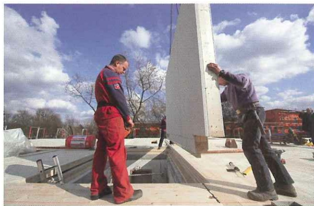
Einpassen der Bauelemente – von Hand.
