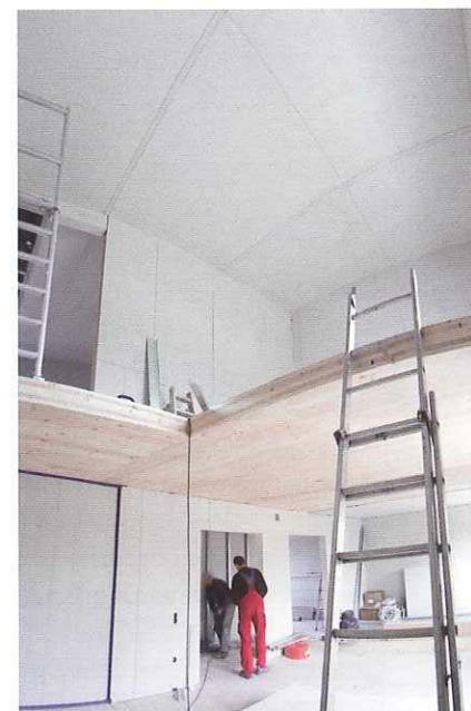
In den nach Süden ausgerichteten Pultbauten entstehen lichte Raumhöhen.
