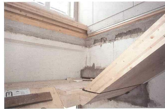
Detailansicht: Treppenaufgang aus Holz, Anschluss Bestand-Aufstockung.
